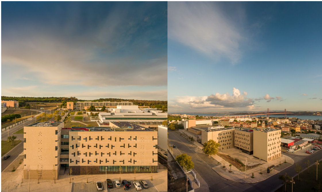
67 Fotografias após conclusão da primeira fase da obra, da autoria de Fernando Guerra.
