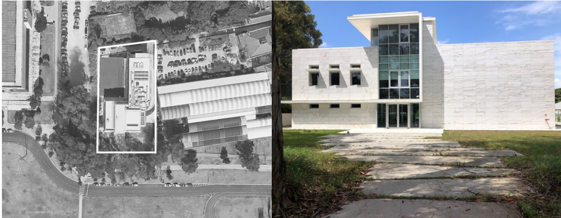
103 Imagem de vista aérea de identificação da Residência Universitária dos Álamos.
