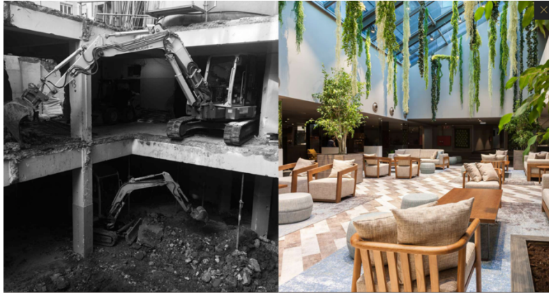
97 Fotografias comparativas o espaço de claraboia proposta, durante as demolições e depois da intervenção.
