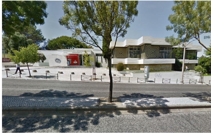
83 Fotografia do alçado sul da Residência da Antiga Cantina 2 da Cidade Universitária.
