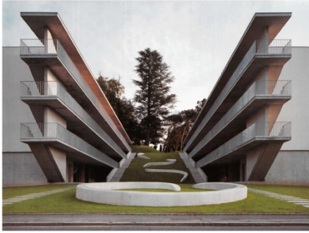
37 Fotografia pelo exterior da residência Casa dell'Accademia, Mendrisio.
